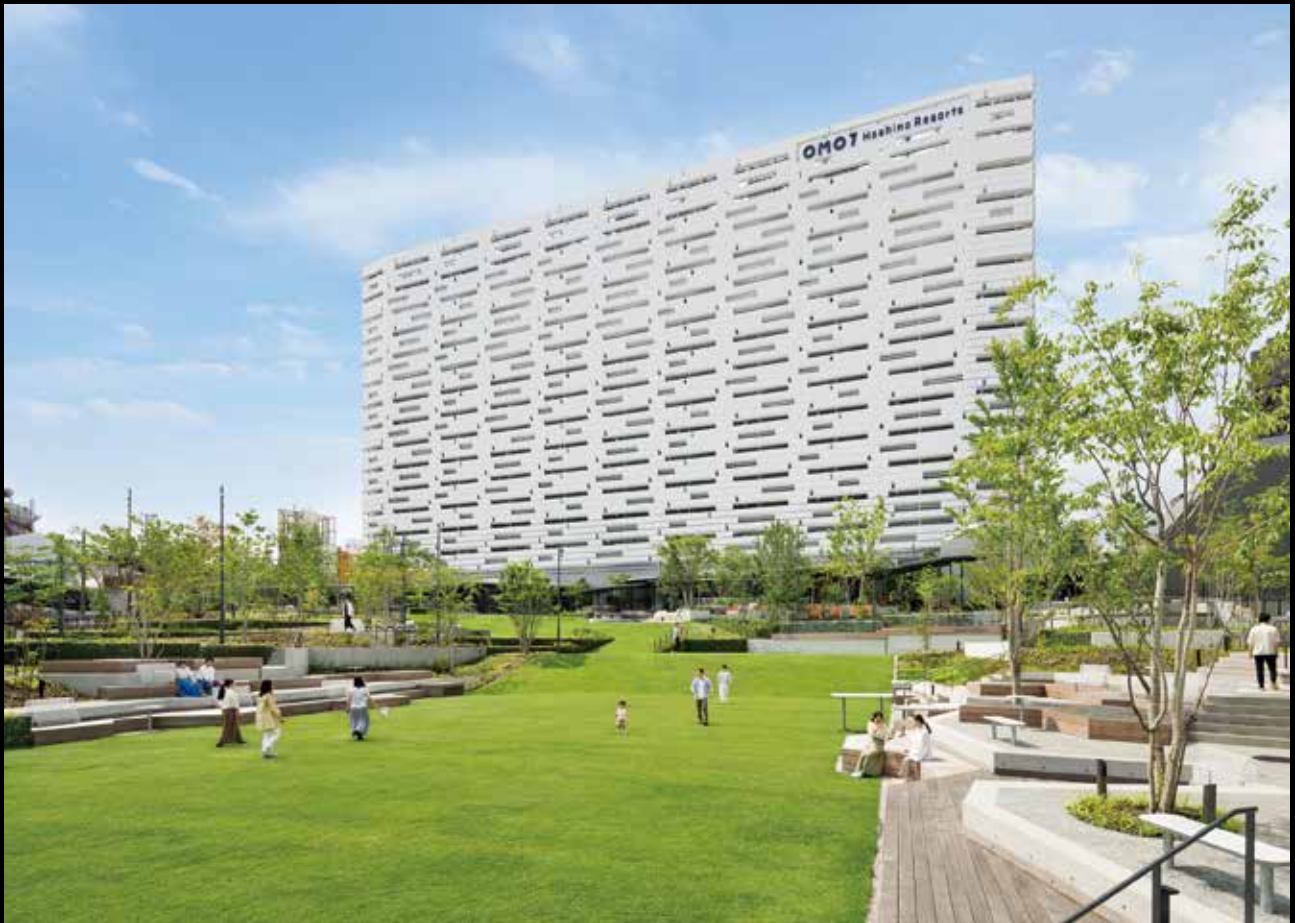
緑化広場「みやぐりん」からみたホテル全景。膜材によってホテルのファサード・デザインを構成している。
