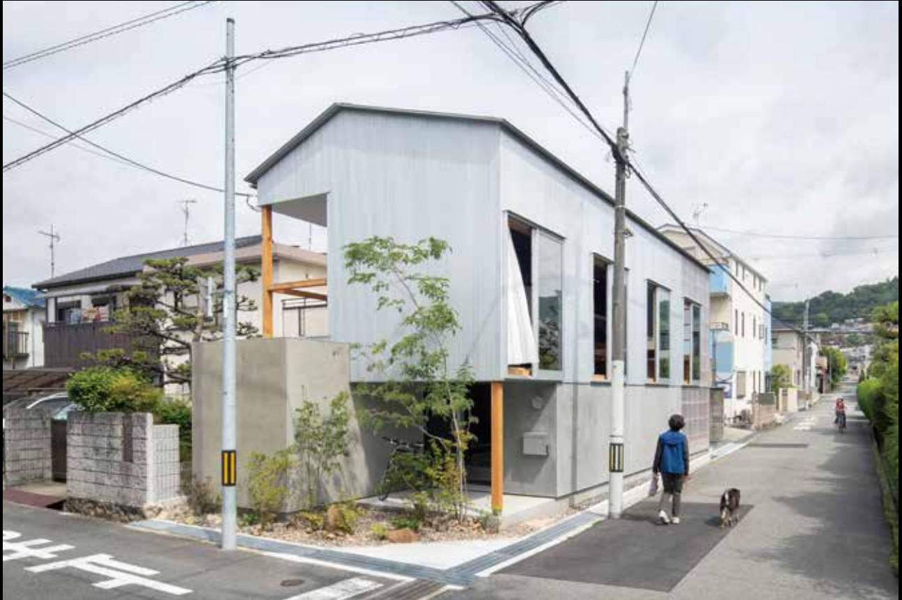
南東外観：周辺の塀と連続したモルタル掻き落としの外壁の上に小屋が乗っかる構成とし、まちに対して小さなスケールの建ち方とした
