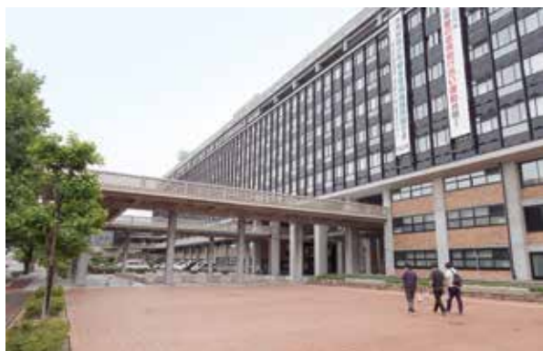
南西側から見る事務棟本館
