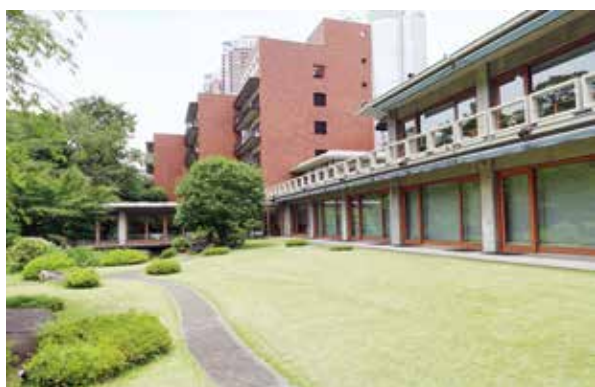
南東から見る本館、地下食堂、新館棟
