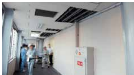
応急危険度判定訓練
