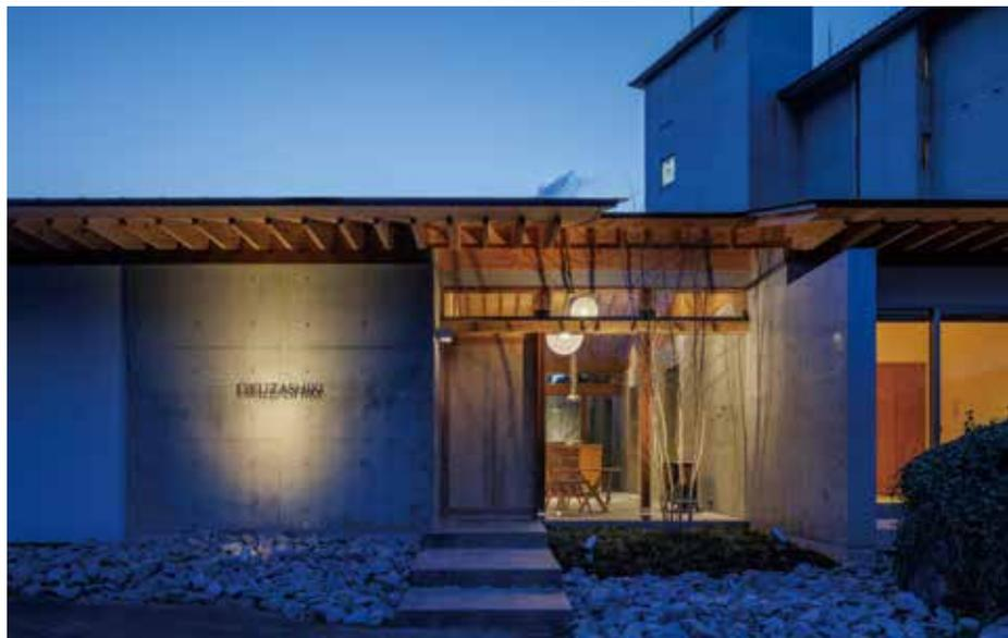
先々代から湯治宿を受け継ぎ、新たな顧客層の開拓を目指した。既存本館の外観を踏襲し、敷地全体として一体感ある風景を形成するとともに、湯治宿の重要な要素である共用台所を中心に、長期滞在客が家に居るようにくつろげる空間を考えた。台所のあるリビングホールは土間床として天井を張らず、視線の抜けを与えることで“屋内でありながら室外である”と定義付け、汎用性向上を狙った。厳しい寒さと盆地性の夏場の暑さを考慮して、自然熱源の冷暖気ファン搬送システムを導入した。平面混構造を採用しRC壁式構造の高耐震性を得つつ木造部分は筋交いなしで垂直力のみ負担させ、躯体コスト低減と工期短縮を図った。
