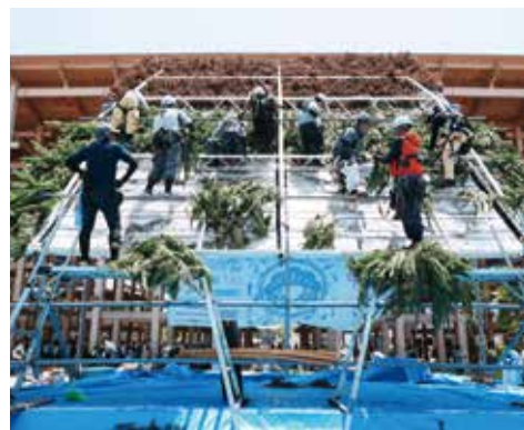
ポップアップステージ西 松葉葺き替えワークショップの様子
