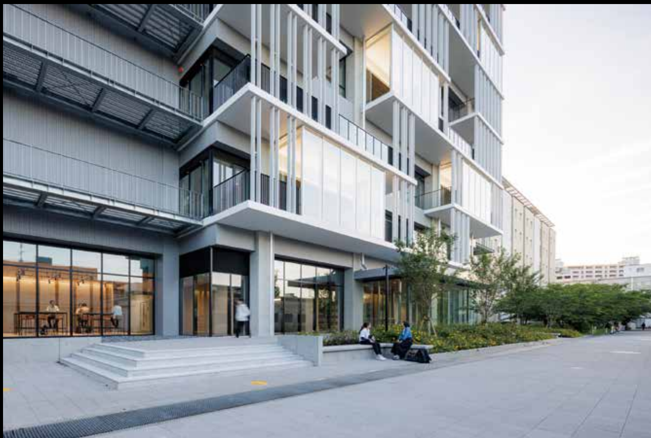
立体的なテラスで内外をつなぐ工学新棟
